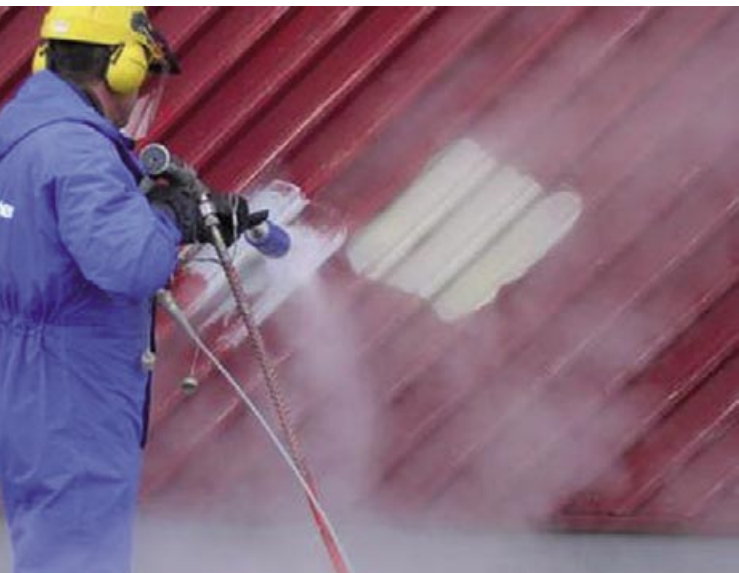
2500 bar Arbeitsdruck und kaltes Wasser lösen selbst die hartnäckigsten Farb- und Lack-Beschichtungen.
