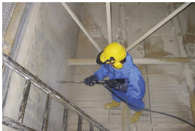
Filterpressen in Klärwerken werden per Hochdruck gründlich und schnell gereinigt. (hier: Dynajet® 500 me )
