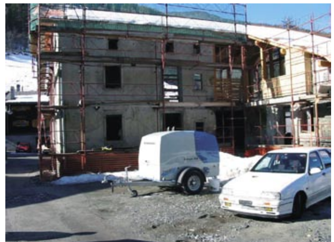
Das historische Museum wurde im Laufe der Zeit verputzt und sollte im Zuge der Restaurierung wieder in den Original-Zustand mit sichtbarem Naturstein-Mauerwerk versetzt werden.
