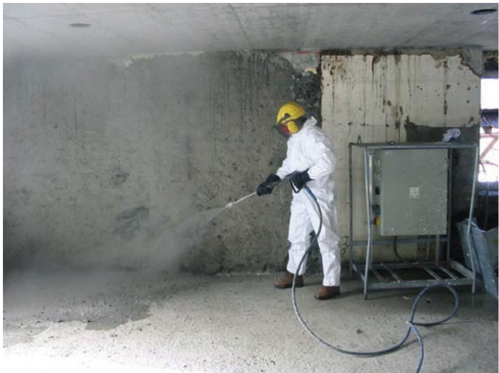
Mit 500 bar Wasserdruck wurde der alte Putz ohne Probleme entfernt – schnell, sauber und staubfrei.
