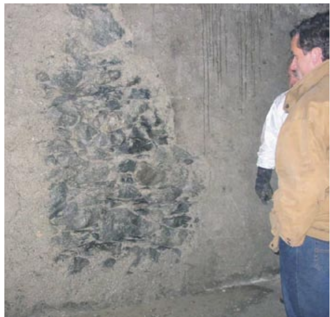
Hier sieht man einen Teil des Original-Granit-Mauerwerks, nachdem ein 500 bar-Wasserstrahl den Mörtel „bearbeitet“ hatte.
